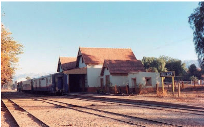
Estación de tren abandonada
